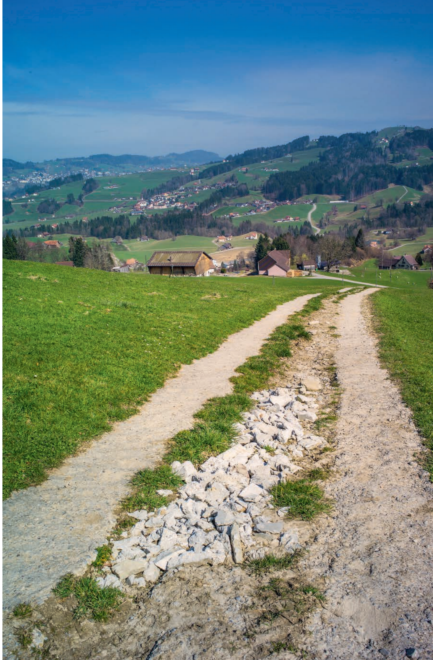
GSCHWEND: Betonierte Fahrspuren erleichtern den Abstieg vom Buechberg zum Hargarten.
